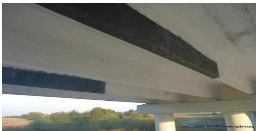
Рис.1. Пример усиления балок пролетного строения
