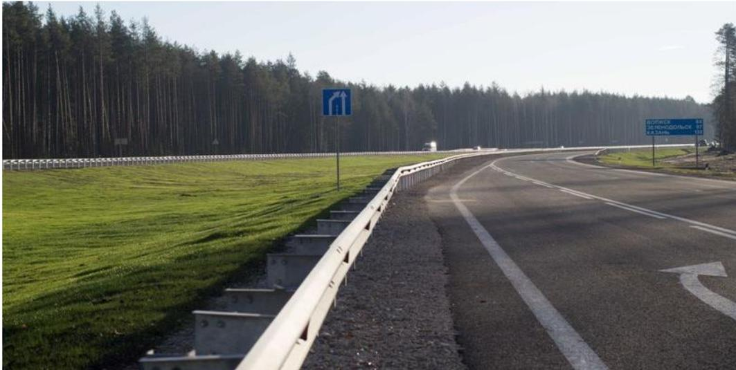
Рис. 2. Необеспеченная видимость на кривой в плане
