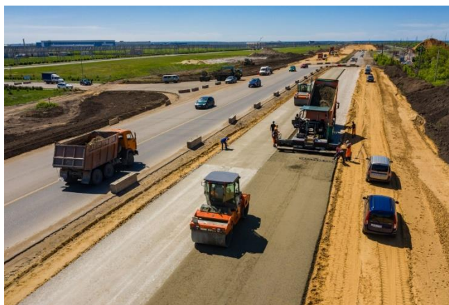
Рис. 2. Процесс строительства дорожно-транспортного комплекса
