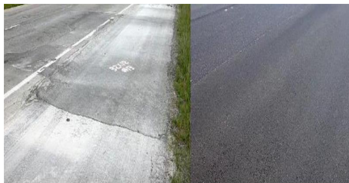
Рис. 6. Дорожное покрытие до (слева) и после (справа)
